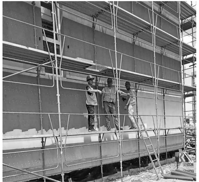
У секції Б тривають роботи з опорядження фасаду – комплекс зовнішніх оздоблювальних і захисних робіт
