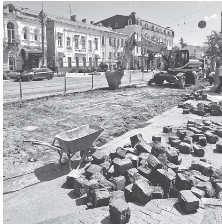
Роботи в центрі міста проводять уже другий рік поспіль. Цього разу разом із бруківкою будуть оновлювати й підземні комунікації
