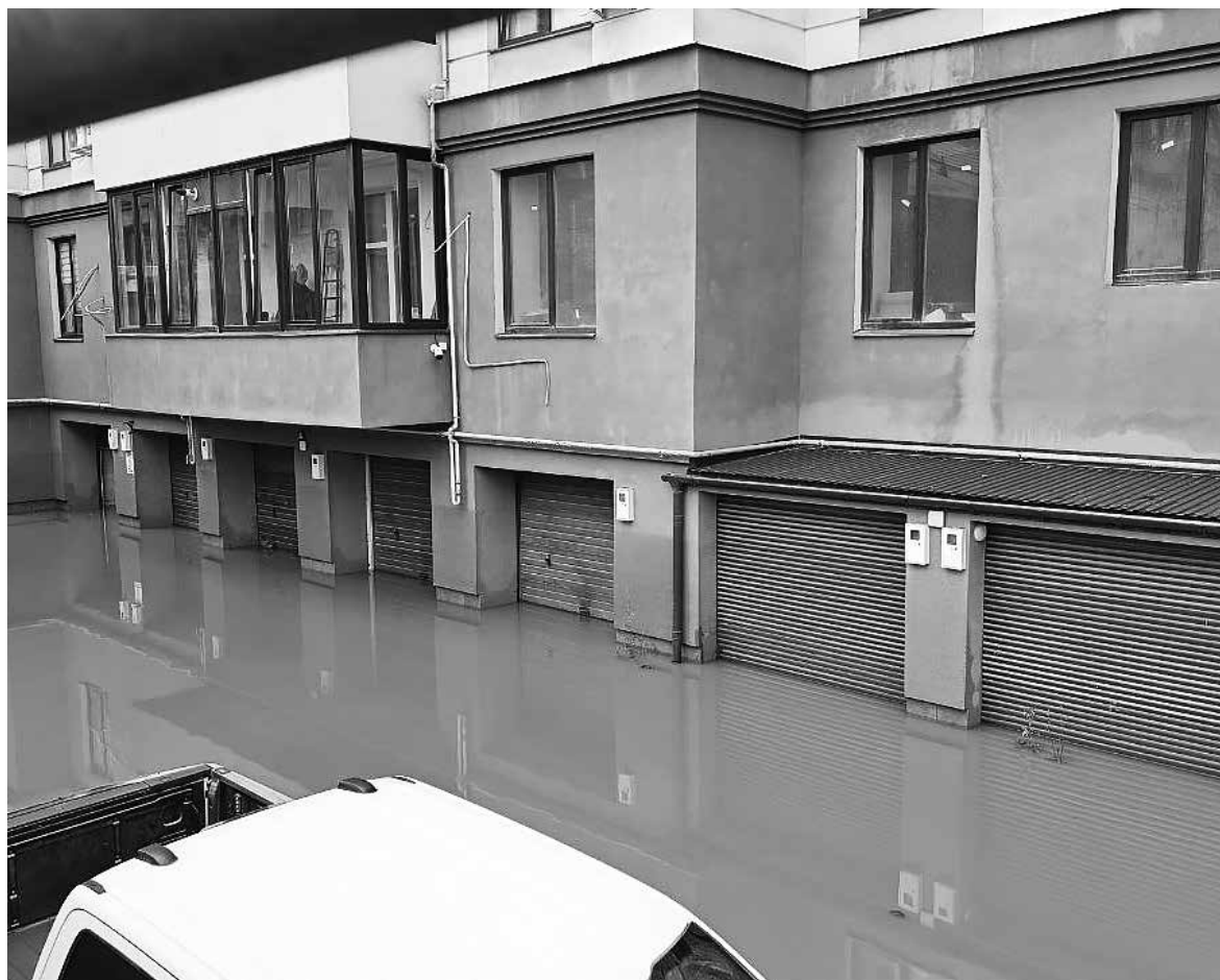
Через підтоплення мешканці боялися заходити у воду, адже там опинилась і електрична підстанція
