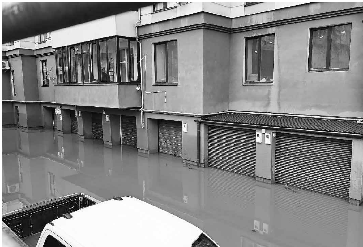
Через підтоплення мешканці боялися заходити у воду, адже там опинилась і електрична підстанція
