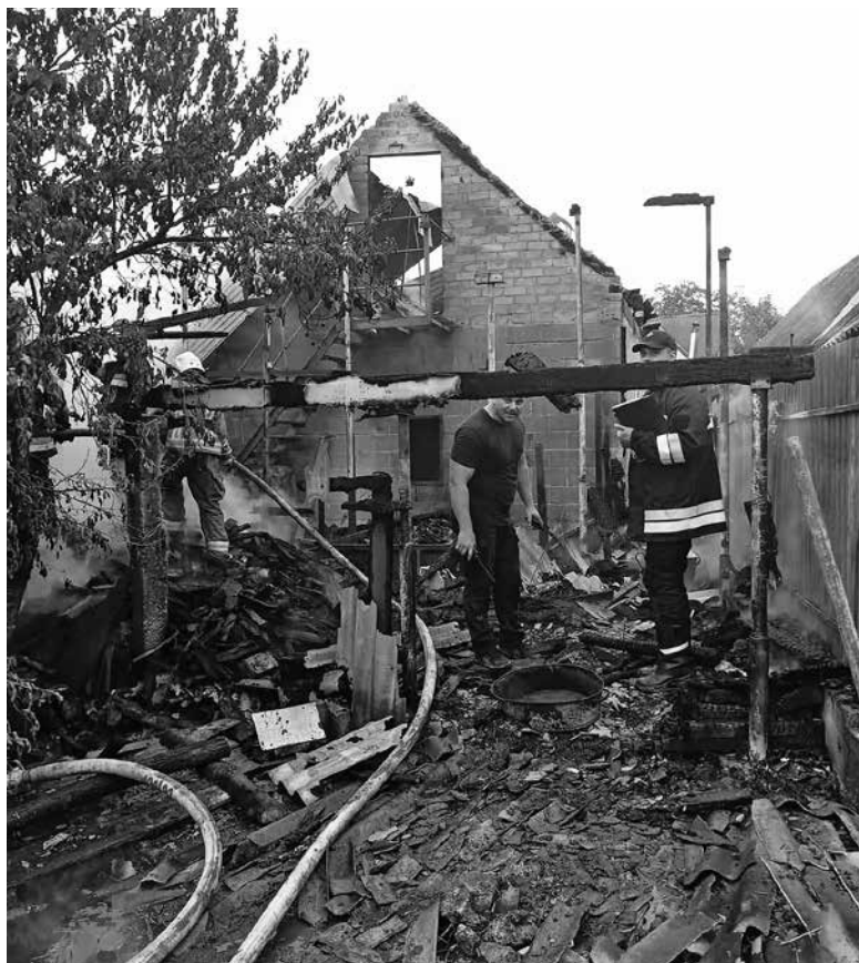
Постраждалі кажуть, що від будинку і господарських приміщень залишилися лише стіни
