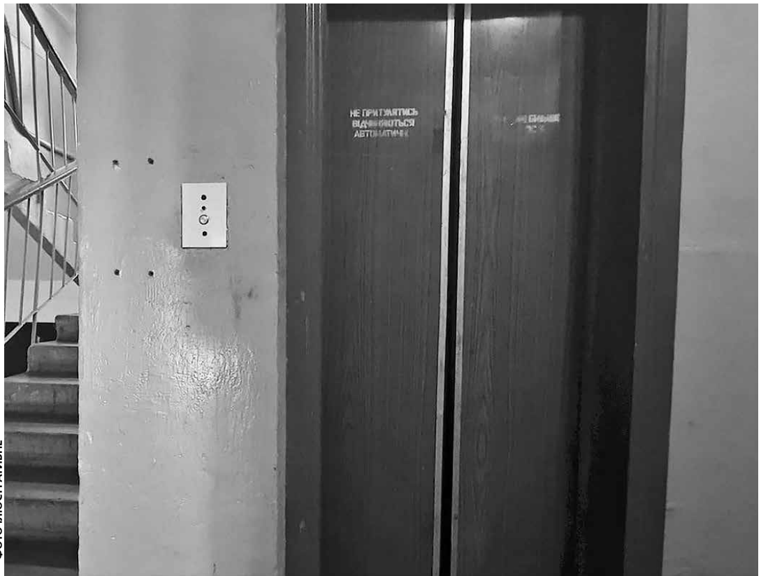
Шість ліфтів запланували відремонтувати у багатоповерхівках в Тернополі
