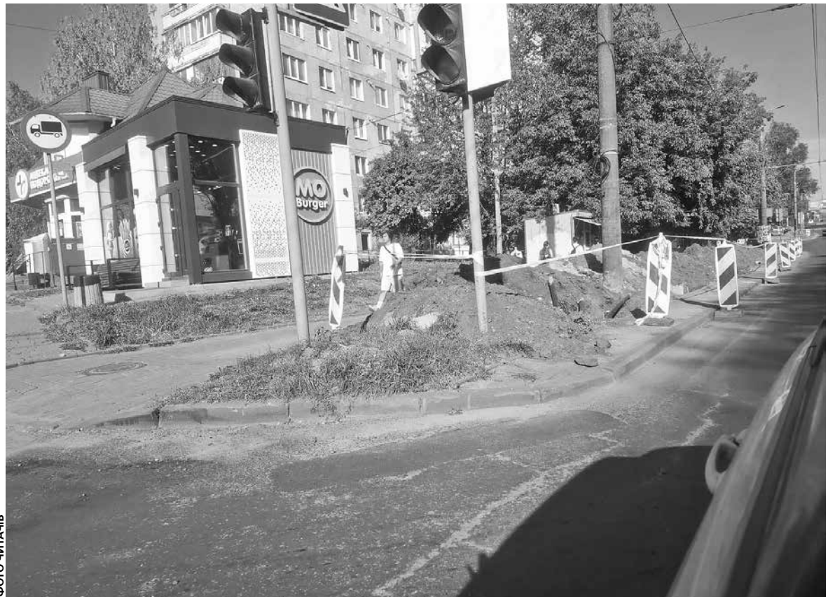
На ділянці, на яку вказують читачі, тягнуть електричний кабель для підсилення електростанції
