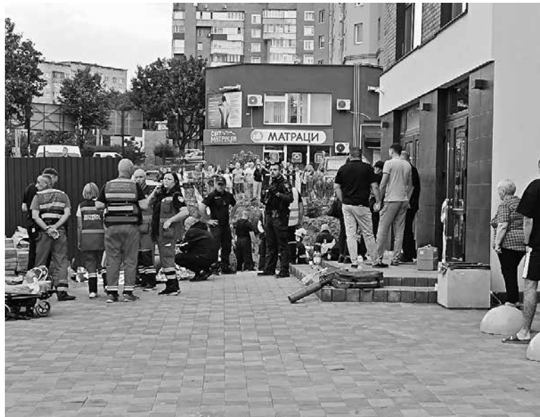
Обвал ґрунту стався під час земляних робіт із заміни каналізаційних труб, повідомили у прокуратурі
