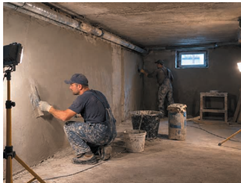
Перед ремонтом буде обстеження. Фахівці визначать, чи можна у підвальному приміщенні створити найпростіше укриття
