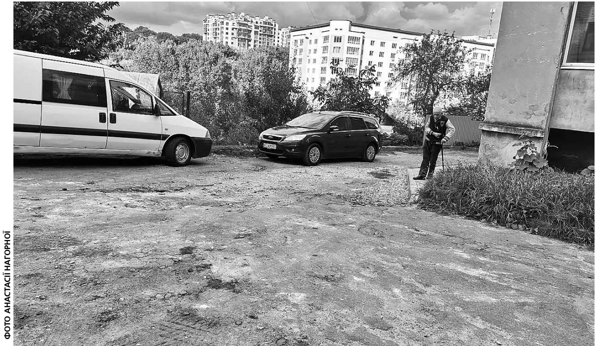
У 2024 році ремонтні роботи біля будинку №37 все ж почали — там облаштували пішохідну доріжку з бруківки. На цьому і завершили
