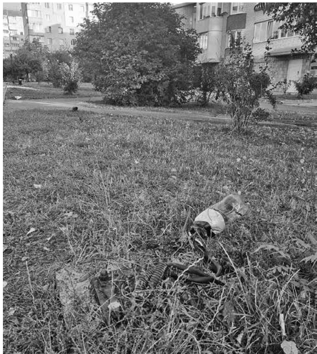
Два ліхтарні стовпи впали раніше. На їх місці тривалий час стирчать ізольовані дроти
